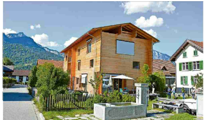
Alpiner Strickbau im Dorfzentrum: Das Mehrfamilienhaus von Matthias und Susanne Frasnelli in Bonaduz.
