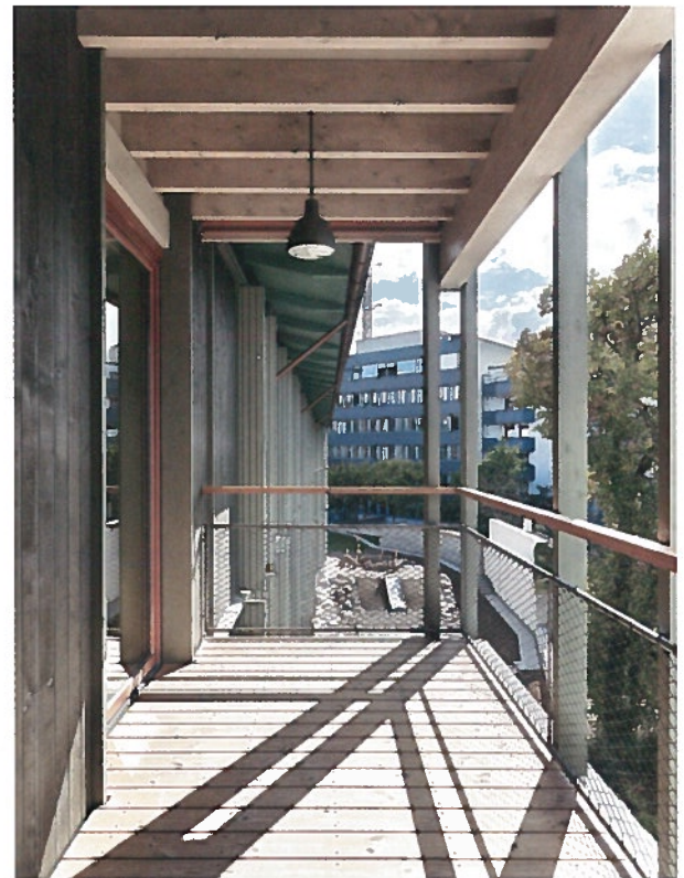
Die Balkone differenzieren das Fassadenbild gegen die Malengasse. Die Tragstruktur im Innern zieht sich auch auf die Überdeckung hinaus.
