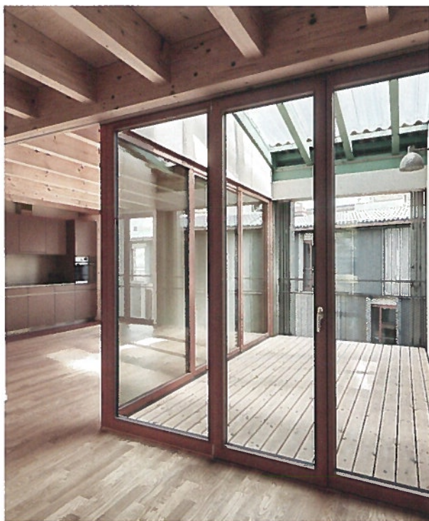
Die massiven Balken sind mit der Primärstruktur ohne Schrauben durch Schwalbenschwänze verkeilt.
