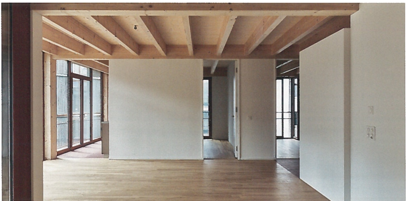
Die Höhe der Räume ist mit 2.76 m grosszügig – die Balkenhöhe von 26 cm kommt zu den in der Stadt Basel gesetzlich erforderlichen 2.50 m hinzu.
