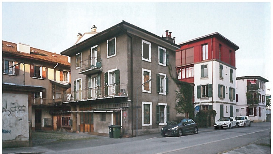
Aufstockung als Wohnraumverdichtung in Vevey.
