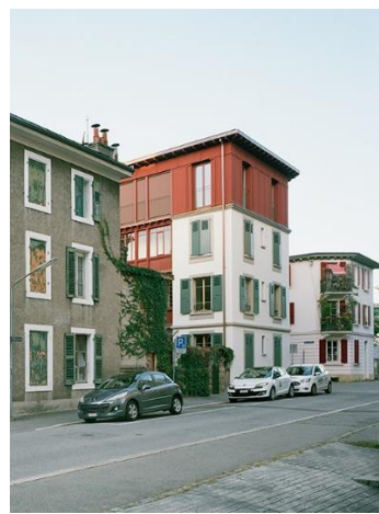
Aufstockung in Vevey
