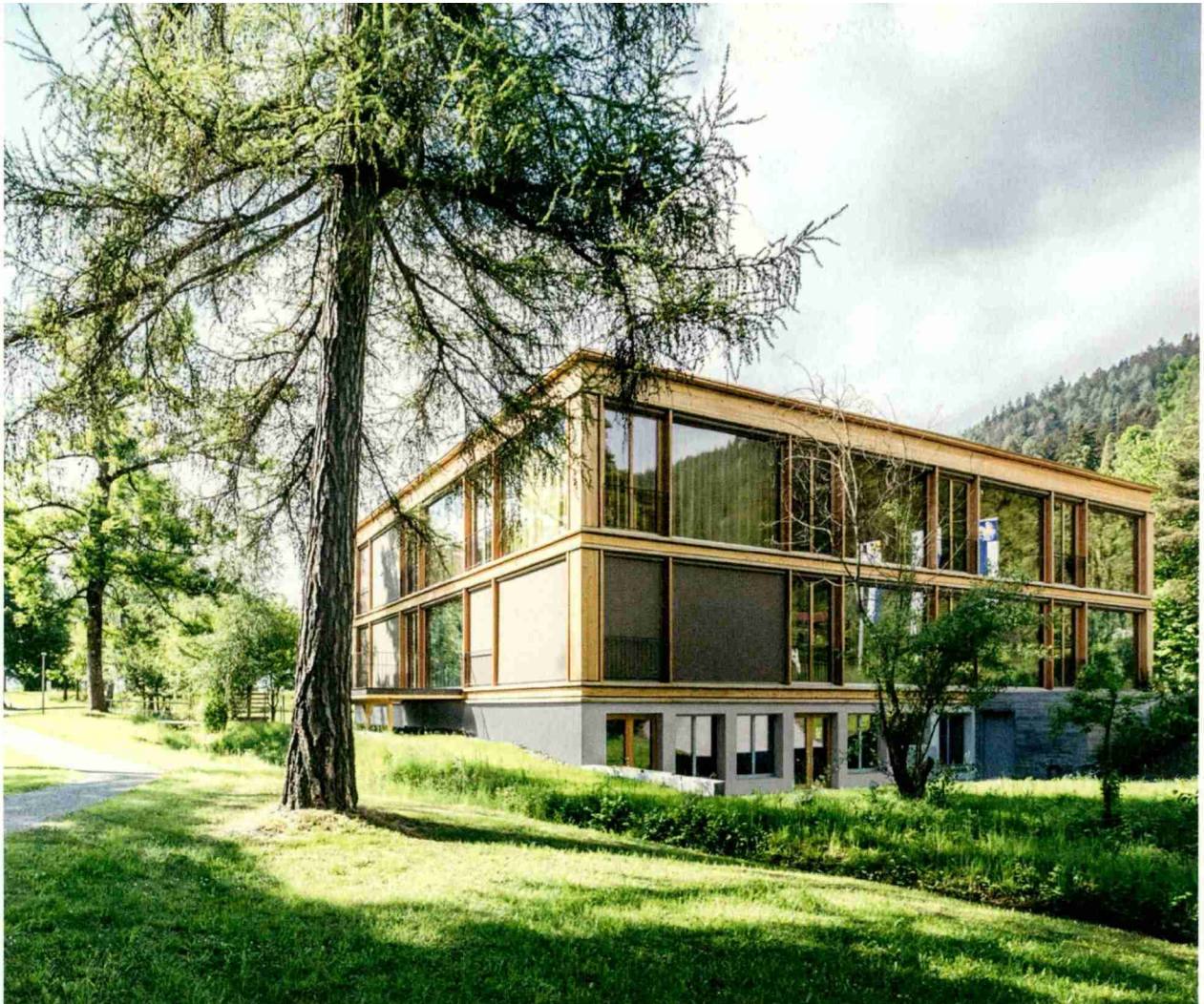
Gesamtsanierung Haus 8, Klinik Beverin in Cazis; Bild: Ingo Rasp
