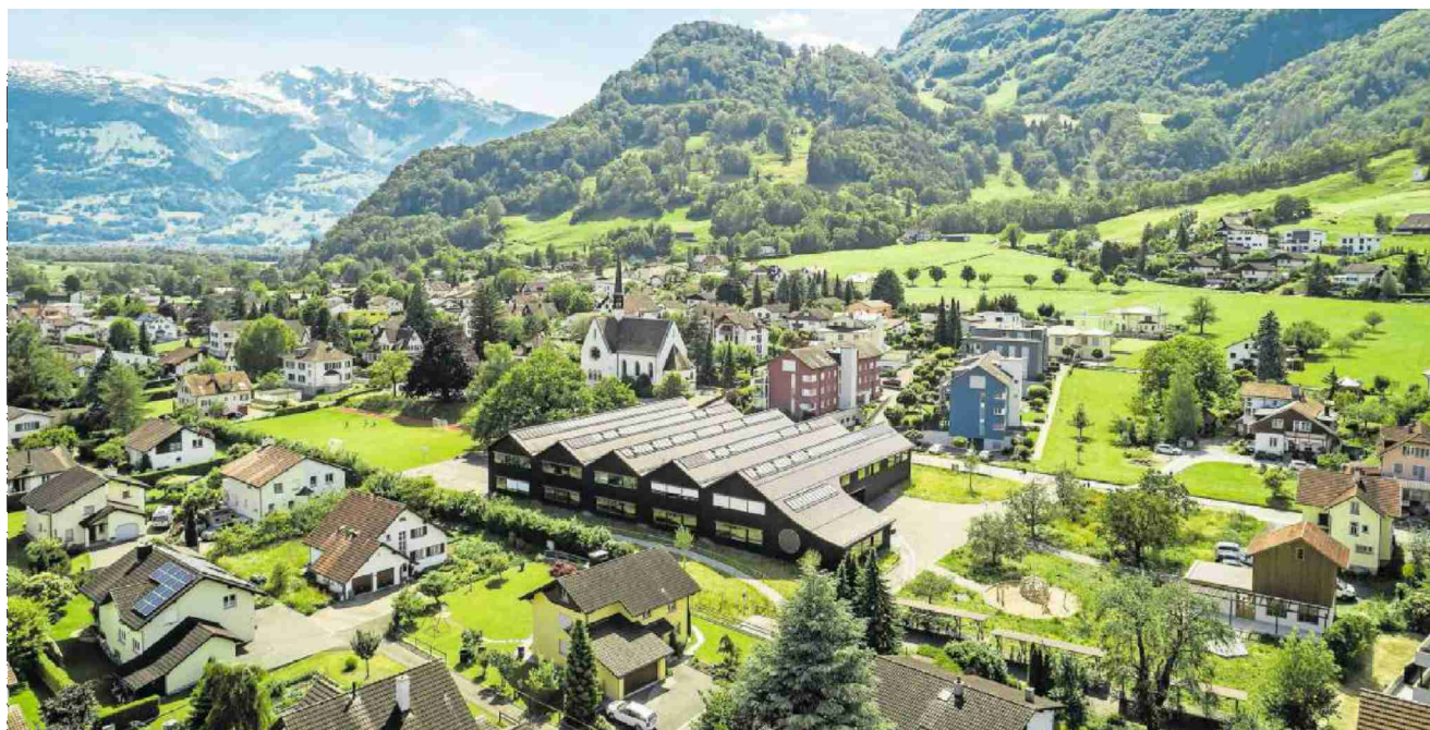
Mehrfach preisgekrönt: Das Azmooser Schulhaus Feld wurde diskret in das Dorfbild eingefügt, trotz doppelter Kapazität.
