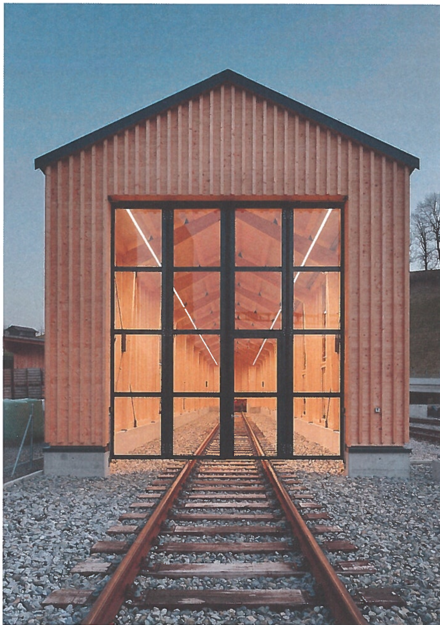
Das Satteldach des Lokschuppens ist mit 25 Grad geneigt.
