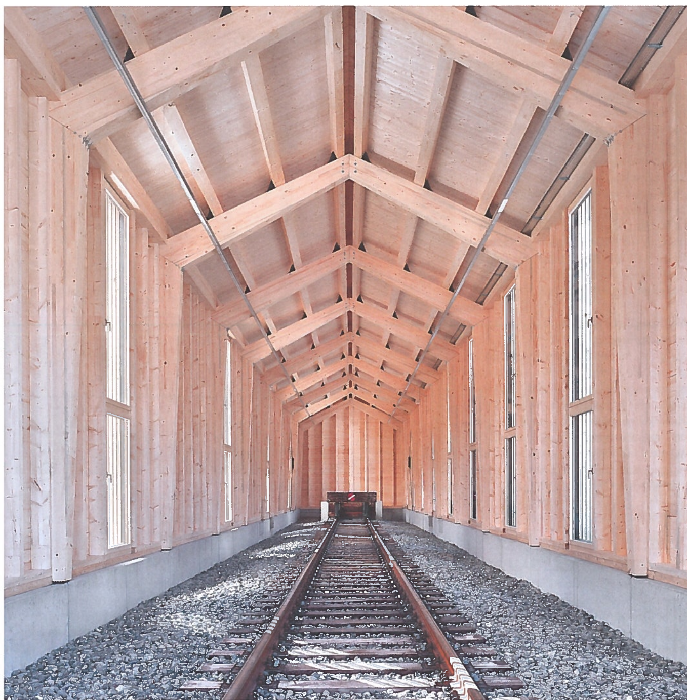
Ein einfacher Dreigelenkrahn aus Schweizer Fichtenholz dient der Lokremise als Primärtragwerk.
