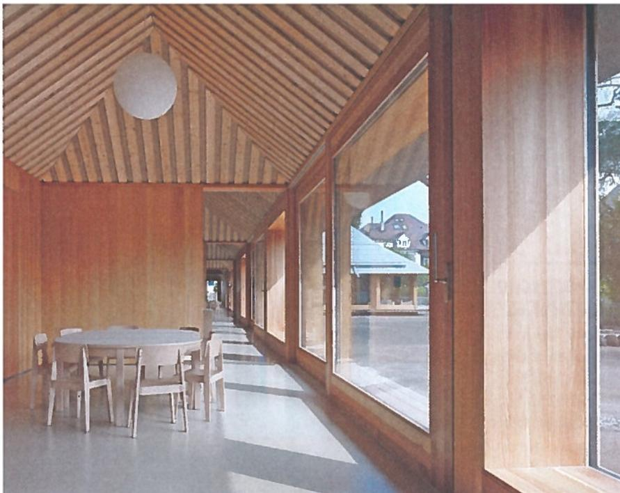
Die Fassade des Doppelkindergartens besteht überwiegend aus Fenstern, deren Rahmen ebenfalls aus Lärche gebaut sind.
